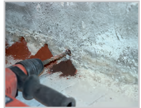
Bij spouwmuren: zowel het binnen- als het buitenspouwblad apart boren
